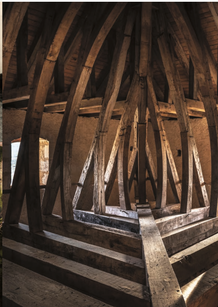
La chapente de la Tour de Vesvre
