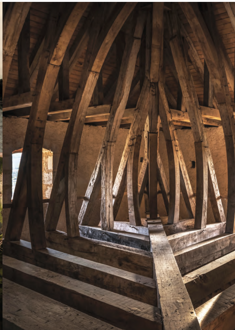
La chapente de la Tour de Vesvre
